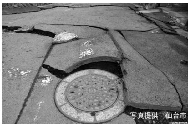
写真-1 アスファルトが損壊した道路
