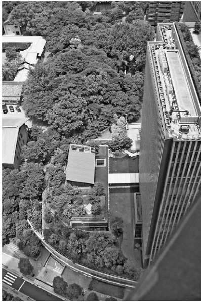
写真3：東急キャピトルタワー 隣接する山王日枝神社の社叢に続く緑のボリュームを形成するために、人工地盤上に厚みのある基盤を確保している。(設計：PLACEMEDIA)
