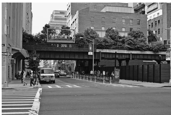
写真2：High Line, New York City 鉄道高架の構造を転用した基盤は、十分な深さの植栽基盤と様々な設備をビルトインできるだけのキャパシティを備えている。
