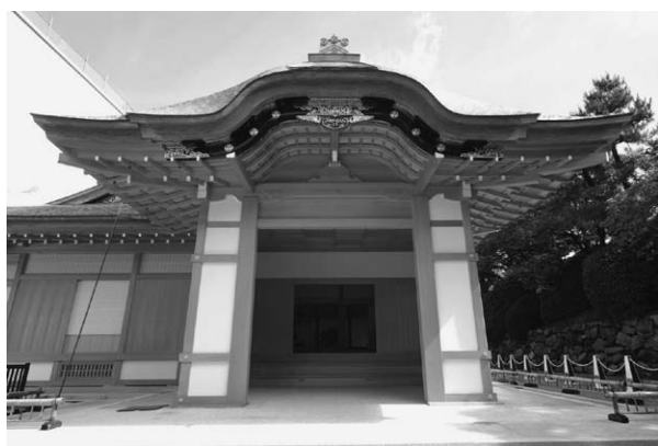
図2 名古屋城本丸御殿 車寄 (提供：名古屋城総合事務所)
