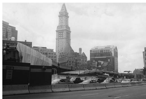
写真10 ボストン・ビッグディック 高速道路地下化、工事中の写真(2004年)
