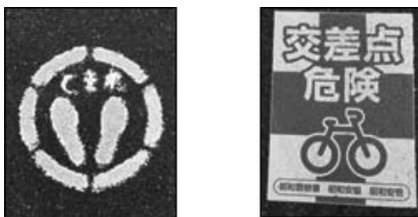
写真4 とまれ足型マーク（左） 自転車交差点危険表示（右）
