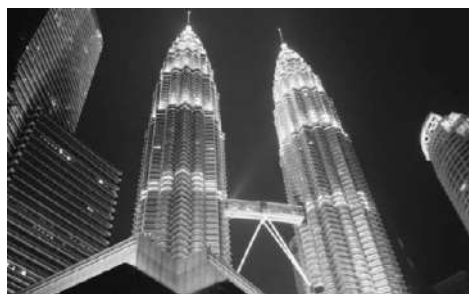
図3 ペトロナスツインタワー
