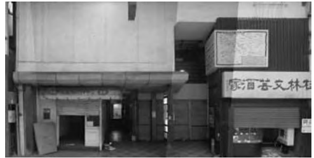
図2 10年間放置されていたビルの再生事例 (北九州市)
