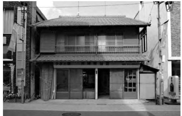
図3 5年間放置されていた住居兼店舗の再生事例 (春日井市)
