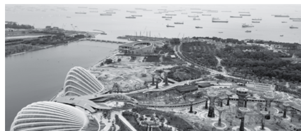
図9 建設中の植物園（後ろには停泊中の貨物船）
