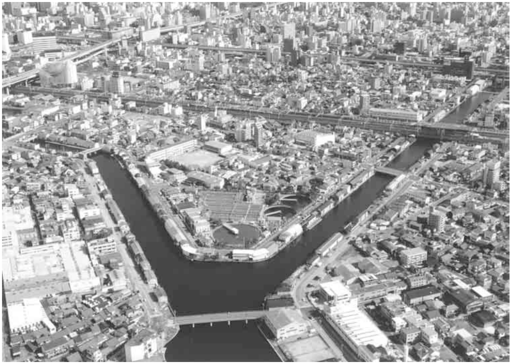
写真1 改築工事前の露橋水処理センター
