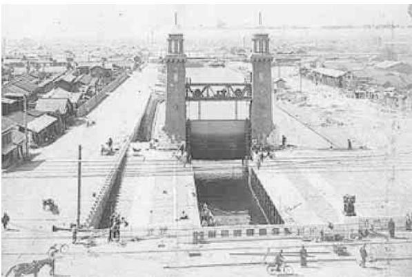
写真2 完成当時の松重閘門
