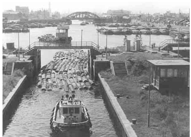
写真１ 中川口閘門と下流に広がる船だまり
