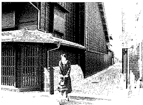
町屋修景(車庫に格子戸、庇修景)
