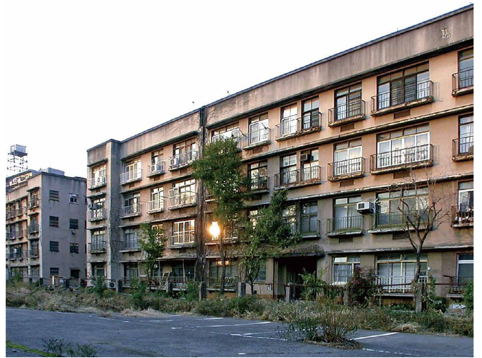
解体前 同潤会江戸川アパートメント 写真提供/橋本文隆氏
