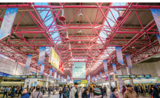
金山総合駅連絡通路橋／名鉄、JR金山駅の接続と南北の横断を目的に整備。幅員約20m、延長約90m、歩いているとわからないが線路をまたぐ横断橋。広い空間を印象付けるトラス構造の屋根が特徴。
