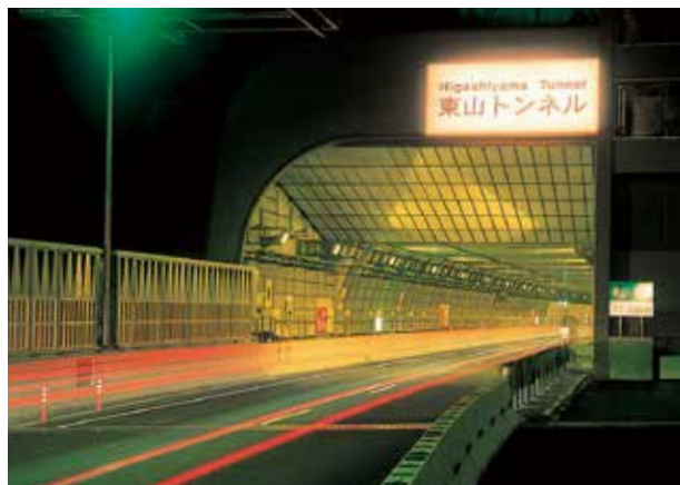
名古屋高速道路の東山トンネル入り口
