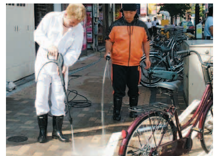
高圧洗浄機による歩道の洗浄
