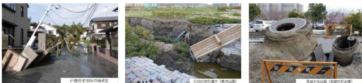
東日本大震災による液状化被害の状況 ※浦安市ホームページより
