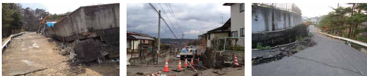
東日本大震災による滑動崩落被害の状況(仙台市) ※名古屋都市センター撮影
